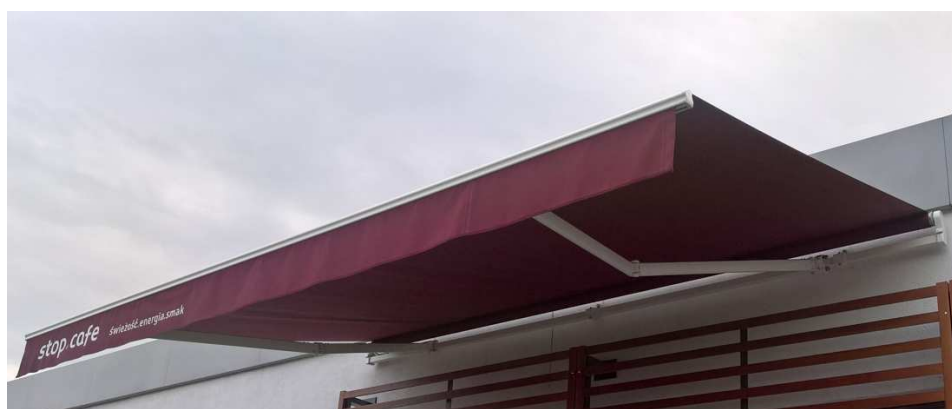
Zdjęcie poglądowe markizy mocowanej do ściany murowanej pawilonu
